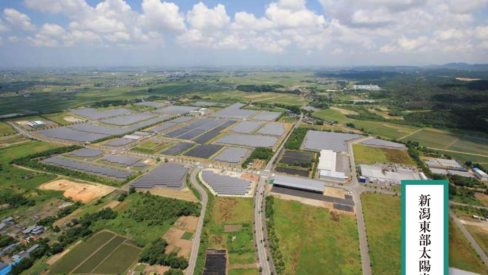
新潟県の発電量は、冬は東京地区を下回るが、春から夏は上回り、「年間の発電量は東京と変わりない」という試算のものとに1号系列を設置。パネルの角度は可動式で、夏は20度、冬は40度にして落雪するように施工。落雪対策としてパネルの架台を高くして(1.8m)、雪が積もってパネルに影ができるないようにパネルの間隔をあけるなどの工夫を凝らしています。新潟東部太陽光発電所に隣接する風の丘公園からメガソーラーを一望できます。
