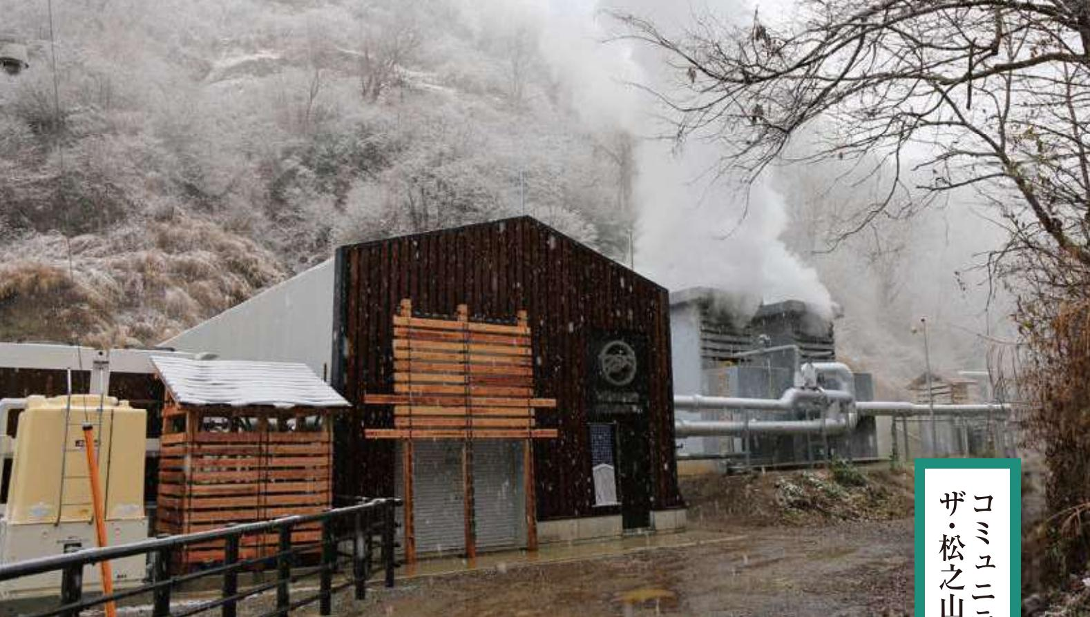
地熱発電には2種類あり、地熱の温度が200°C以上ならば、その蒸気でタービンをまわすフラッシュ発電が可能です。しかし、松之山温泉の温度は約98°C。そのため沸点が低い代替フロンを源泉の熱エネルギーで沸騰させて蒸気を作り、その蒸気でタービンを回すバイナリー発電を採用。全国でも珍しい地熱発電だから話題性もあり、地域の活性化、観光面での集客にも波及効果が期待できます。
