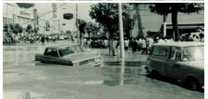
1964年6月13日13時1分に発災した新潟地震。市の中心部が液状化し、石油タンクの火災、昭和大橋の落橋など大きな被害をもたらしました。
